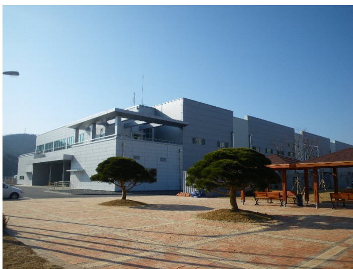
<PCT社の工場外観>
