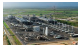
PNG LNGプロジェクトの設備 (パプアニューギニア)
