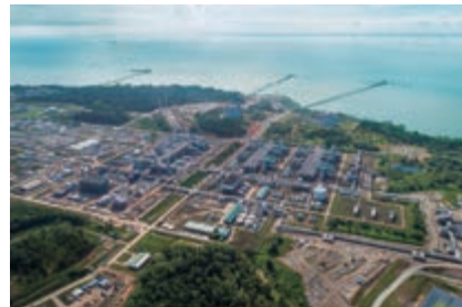
タングーLNGプロジェクトの天然ガス液化設備 (インドネシア)
