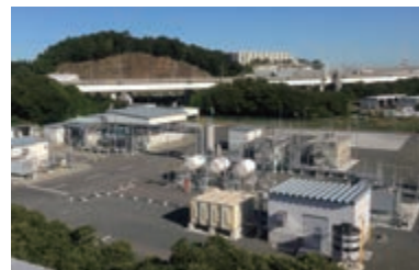
水素製造出荷センター（横浜市中区）
