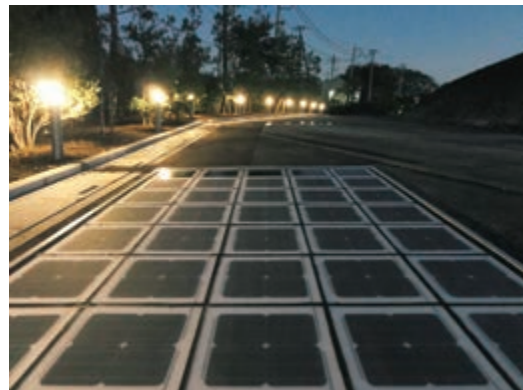
太陽光発電舗装「e-Smart ROAD」
