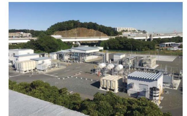
水素製造出荷センター(横浜市中区)
