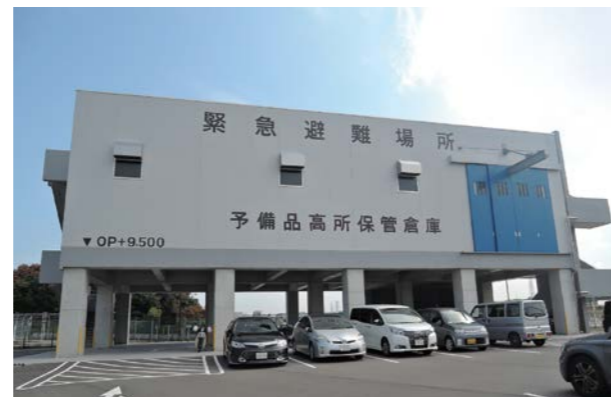
高所保管倉庫(堺製油所)
