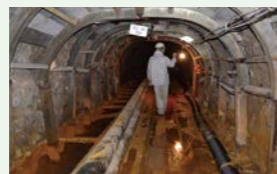
花輪鉱山 坑道点検の様子
