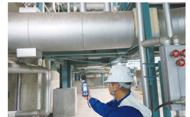
騒音測定の様子
