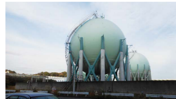
球形タンクのブレース(筋交い)補強
